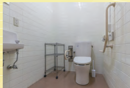
車いす用トイレ
